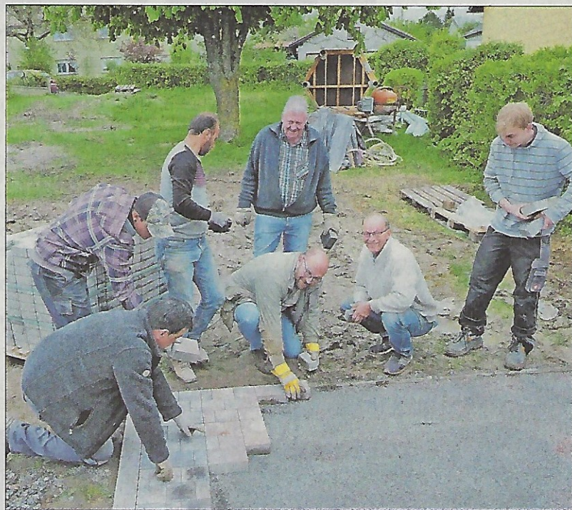
Ende April verlegten die Helfer Pflastersteine am Spielplatz in der Steinkallenfels-Straße.
